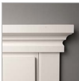
lišta i korunka jsou stříkané
